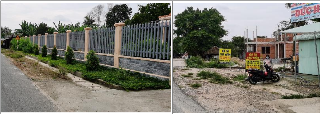
Hình 16. Hệ thống thoát nước chung dọc theo các trục đường Hùng Vương
